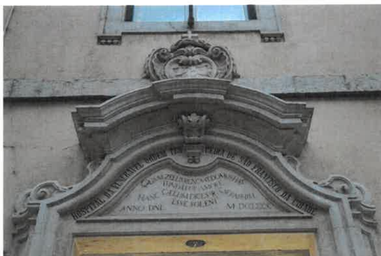
Pórtico da entrada do Hospital da Ordem Terceira da Cidade
